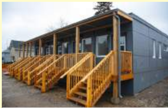
67- Projet pilote de micro-maisons à Oshawa
