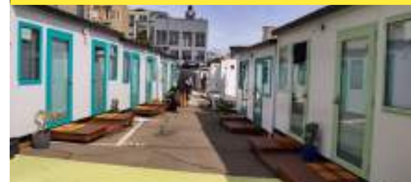
66- Projet DignityMoves San Francisco © DignityMoves
